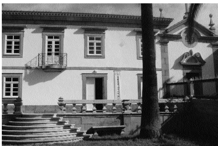
FIG. 14. O SOLAR DOS GOULÕES, HOJE MUSEU DO CANTEIRO.
