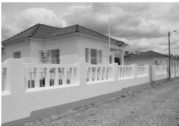
FIG. 15. O EDIFÍCIO QUE IRÁ ALBERGAR BREVE- MENTE O MUSEU GEOMINEIRO DE IDANHA, EM SEGURA.
